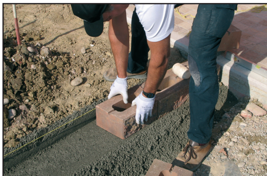
3) Posa della prima riga su piano di calcestruzzo
