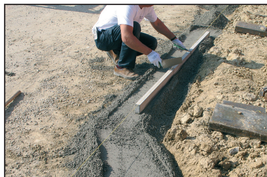
2) Stesura piano di posa
