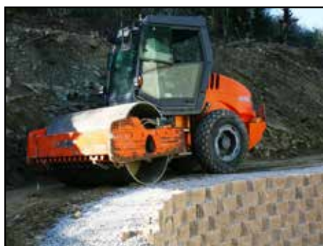
11) Compattazione del terreno
