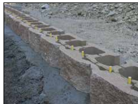
3) Sistemazione ed allineamento del ricorso di base con aggiunta dei pin
