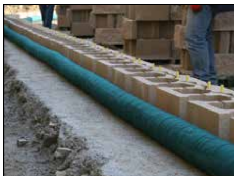
4) Posizionamento del tubo drenante
