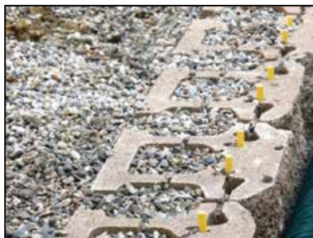
5) Realizzazione e riempimento dello strato drenante
