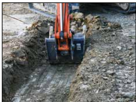
1) Scavo della trincea di base
