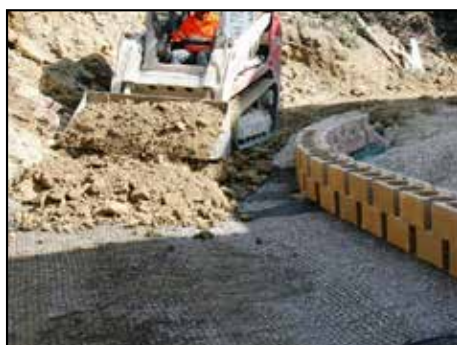
10) Riempimento del terreno
