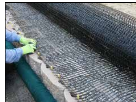
6) Ancoraggio della geogriglia (se prevista a progetto)
